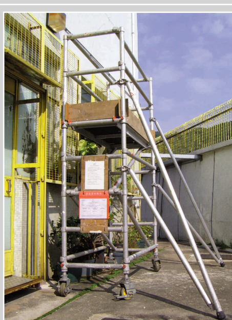
流動式棚架配備可伸延支架、可錨定的滑輪、上落梯及適當工作台
