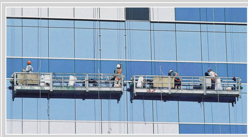
吊船在外牆進行 維修 / 清潔
