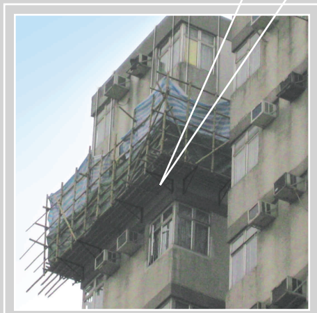
「狗臂架」式棚架及工作台
