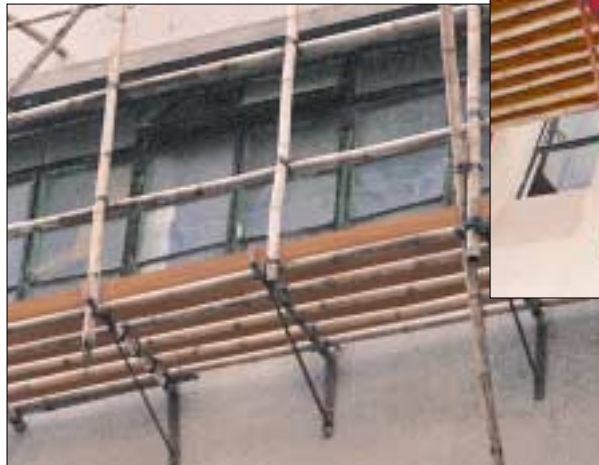
懸空式竹棚架應設有適當工作平台，其底部要有足夠的支承架。
