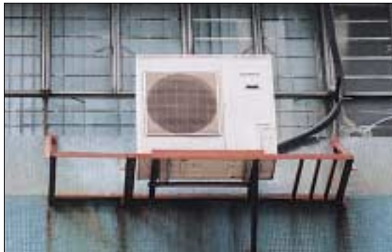
在外牆安裝分體式冷氣機是常見的高空工作。
