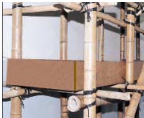
工作平台應以橫竹作護欄、設有底護板及以木板鋪密*。
