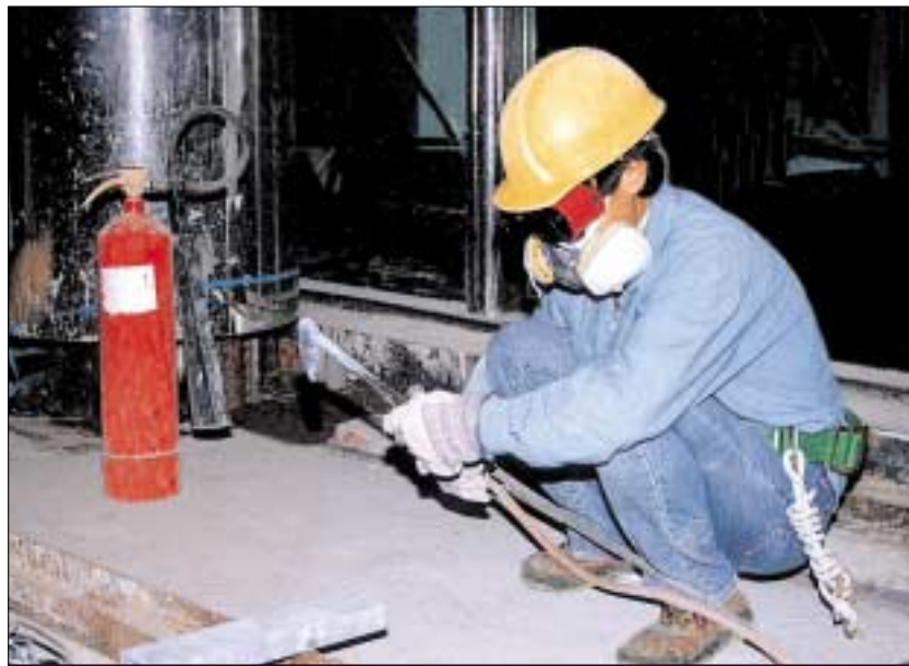
燒焊工序應在空氣流通的地方進行，工人須曾接受安全訓練，並配戴合適的個人防護裝備。
