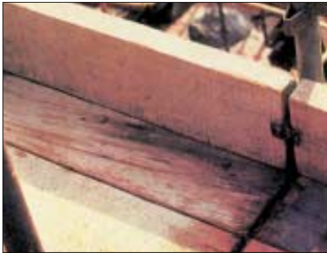
雙行金屬棚架的工作平台應設有護欄、底護板及以木板鋪密*。
