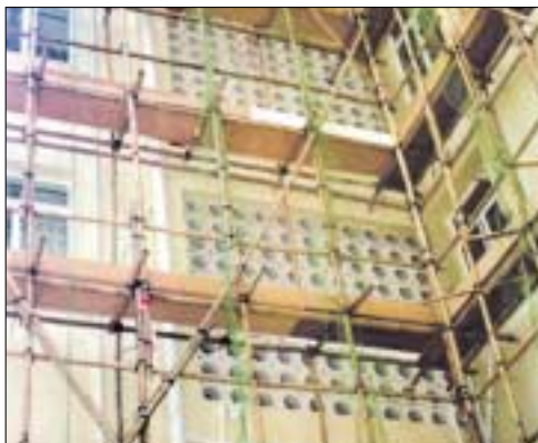
竹棚應為雙行構造(雙棚)以提供適當的工作平台*。
