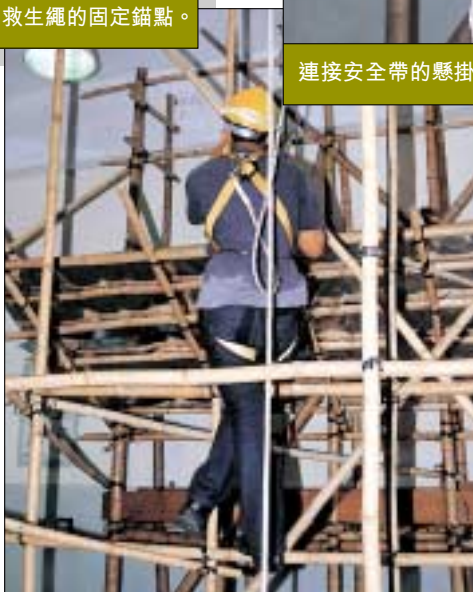
安全帶必須繫於可承受不少於5000牛頓拉力(約510公斤拉力)的固定錨點或獨立救生繩上。
